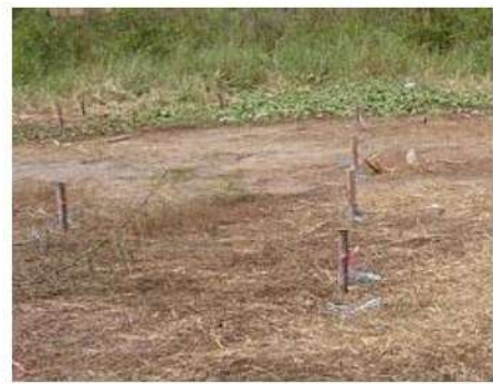
ภาพซ้ายมือ คือหมุดสำหรับตอกเสาเข็ม ต้องตอกให้จมอย่างนี้ ส่วนภาพขวา เป็นหมุดสำหรับตอกเข็มเช่นกัน แต่ตอกไว้ลอยๆอย่างนี้ไม่ถูกต้อง
