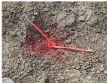
ภาพซ้ายมือ คือหมุดสำหรับตอกเสาเข็ม ต้องตอกให้จมอย่างนี้ ส่วนภาพขวา เป็นหมุดสำหรับตอกเข็มเช่นกัน แต่ตอกไว้ลอยๆอย่างนี้ไม่ถูกต้อง
